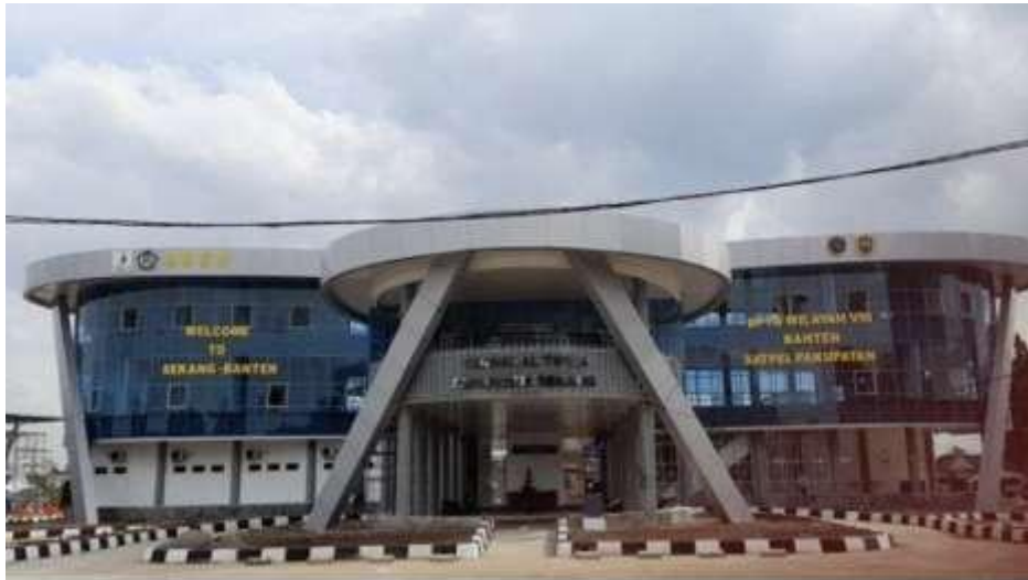
Terminal Pakupatan Tipe A. Pembangunan Terminal Pakupatan tipe A di Kecamatan Cipocok Jaya, Kota Serang masuk tahap penyelesaian. Untuk pembangunan ditargetkan selesai sebelum 19 Februari 2023.
